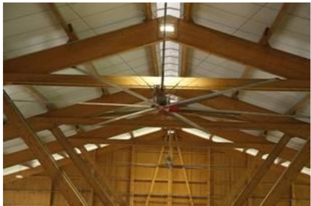
Die beiden grossen Lüfter an der Decke fielen
