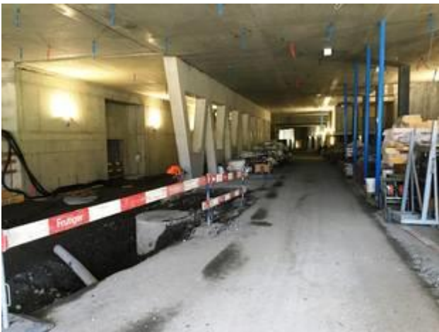
Terminal Grindelwald Grund. Hier werden die Busse und Cars die Gäste im trockenen abladen können. Flächendeckend werden Rolltreppen und Rollbänder zum Einsatz kommen.
