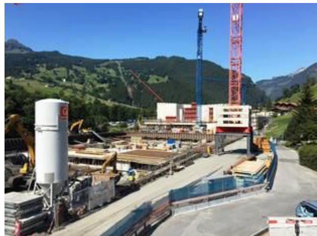
Hier entsteht ein Parkhaus für 1'000 Pkws
