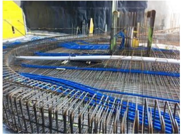
Durchbruch für den Transport von Nahrungsmittel (3S-Bahn - Jungfrauochbahn). Zum Einsatz kommt ein Förderband. Starke Armierung ist gefragt. Bergstation 3S-Bahn auf dem Eigergletscher.
