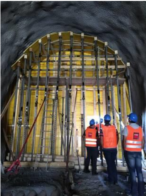
Durchbruch für den Transport von Nahrungsmittel (3S-Bahn - Jungfrauochbahn). Zum Einsatz kommt ein Förderband. Starke Armierung ist gefragt. Bergstation 3S-Bahn auf dem Eigergletscher.
