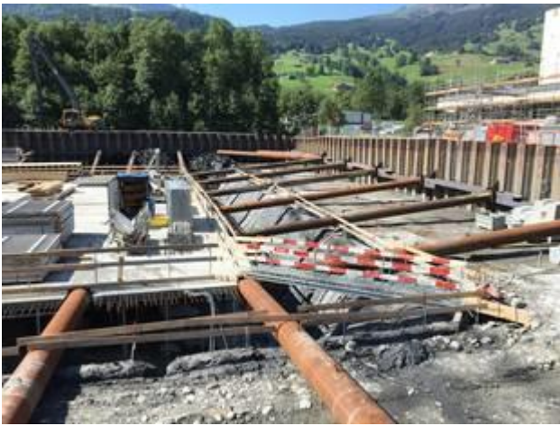
Baugrube für das neue Parkhaus
