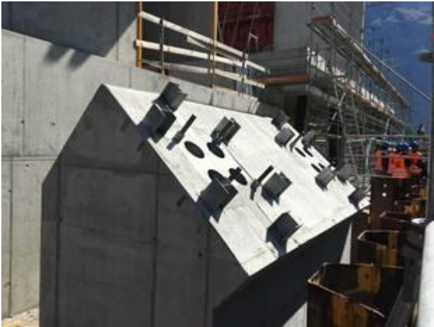
Mastsockel der neuen 3S-Bahn
