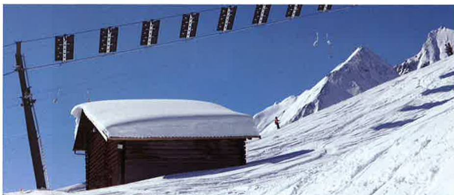
82 Solarflügel an Tragseilen befestigt, produzieren jährlich 90'000 kwh Strom (P. Montagna / www.skilift.tenna.ch)
