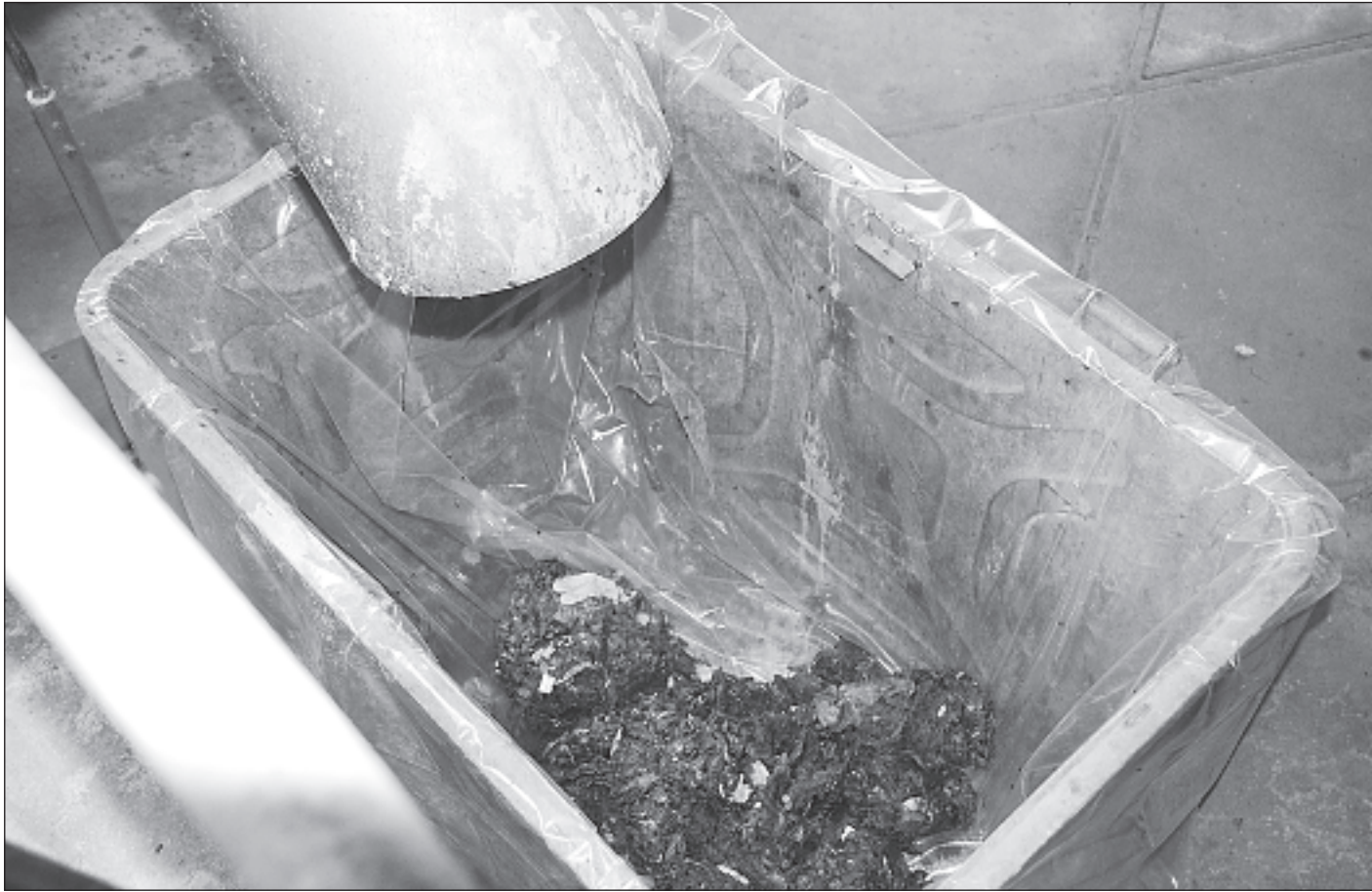
Grobabfälle, die der Rechen aus dem Abwasser holte.
