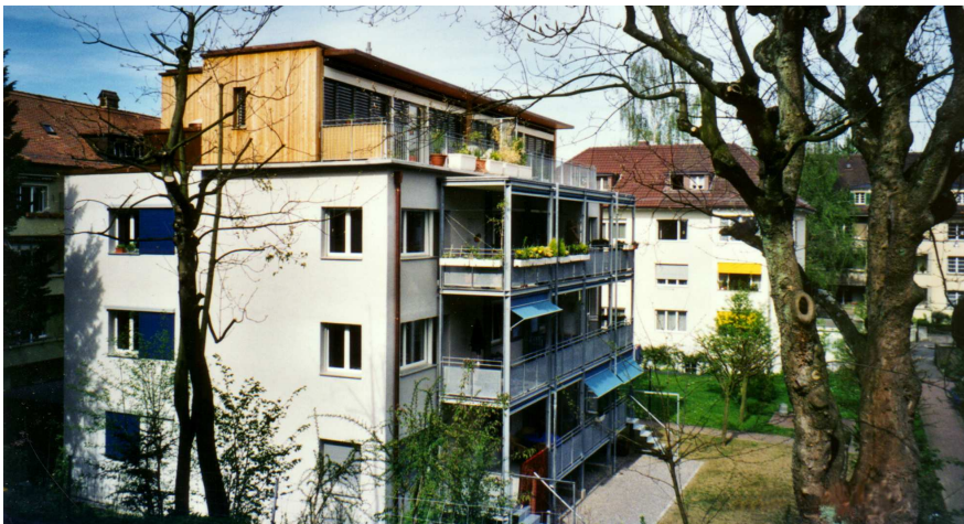
Aufstockung Wohngebäude Bern
