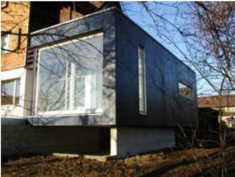
Anbau an bestehenden Wohnhaus Lyssach
