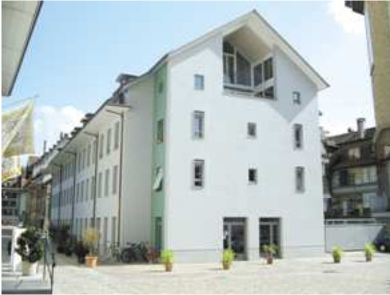
Wohn- und Bürogebäude Kornhausgasse Burgdorf
