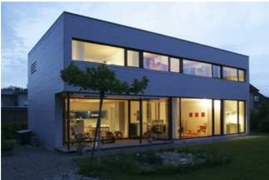
Neubau Einfamilienhaus Burgdorf
