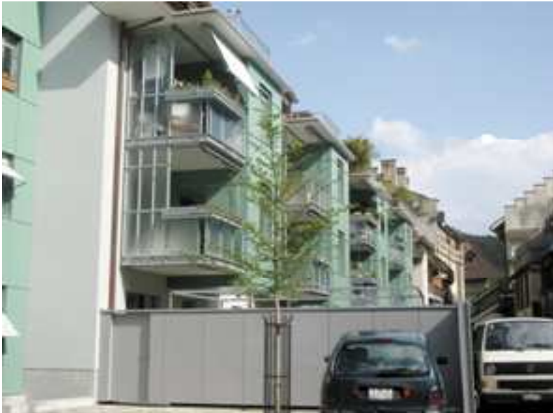
Wohn- und Bürogebäude Kornhausgasse Burgdorf
