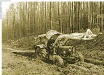
Einzug der Forstspezialtraktoren; Gesamtgewicht Lastwagen CH 28 to, Breite 230cm
