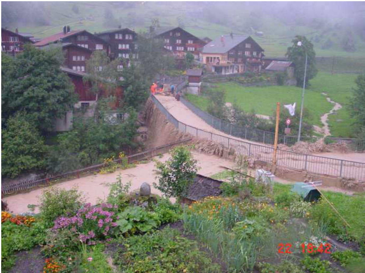
Abb. 4. Die Aare fliesst 2005 durch das Dorf Guttannen und via Brücke wieder zurück in ihr Flussbett (H. Ablanap)
