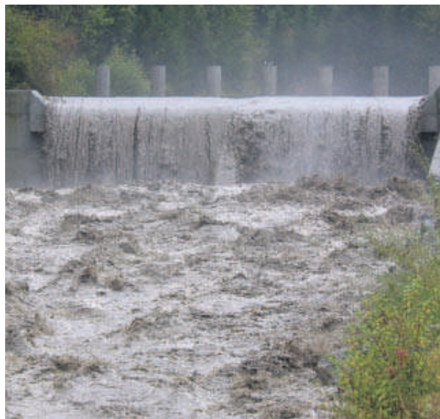
Extremereignisse wie das Unwetter 2011 dürften in Zukunft häufiger auftreten. Schutzmassnahmen wie hier bei der Kiene sind deshalb nötig.
