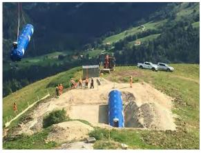
Die drei Tanks haben je eine Abmessung von 19 m Länge und 2.20 m Durchmesser sowie ein Gewicht von je 3 Tonnen. Einzig noch sichtbar sind die «Schachtdeckel». Damit ist das Tränkewasser für die Tiere sichergestellt.
