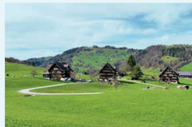
Stattliche Bauernhäuser bilden eine historisch wertvolle Baugruppe. Die Gebäude weisen steile Satteldächer auf. Die Häuser beeindrucken durch ihre Grösse und die handwerkliche Ausführung. Vor wenigen Jahren wurde das westseitige Gebäude (im Bild links) mit einem geschickt geplanten Anbau erweitert und die neue Zufahrt mit einer sorgfältigen Linienführung schön in die Landschaft eingebettet / Niederhufen, Nesslau.
