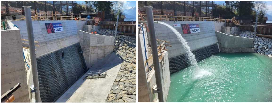
Einlaufbauwerk: Montage Grobrechen und Flutung der Baugrube
