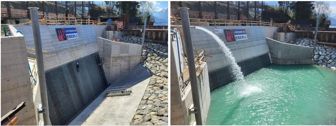
Einlaufbauwerk: Montage Grobrechen und Flutung der Baugrube
