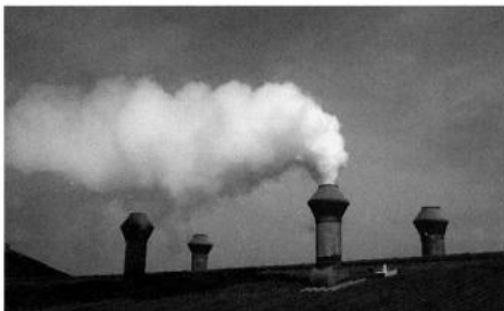
Abb. 1. Die Abluft aus Tierhaltungsanlagen kann zu Geruchsbelastungen führen. Durch geeignete Massnahmen (Stallsystem, Lüftung, Fütterung, Abstände) kann diese Belastung auf ein vertretbares Mass reduziert werden.
