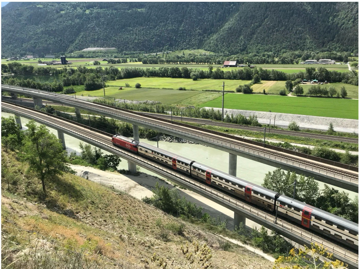
Tunnelportal Lötschbergbasistunnel in Raron, Foto: Thomas Egger
