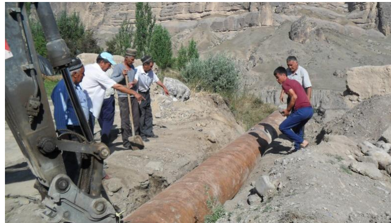
Installation d'un canal de drainage des boues dans le village Oftobruy (Devashtich)
