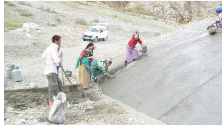
Construction d'infrastructures de protection avec contribution des villageois de Bobuchak, District Devashtich
